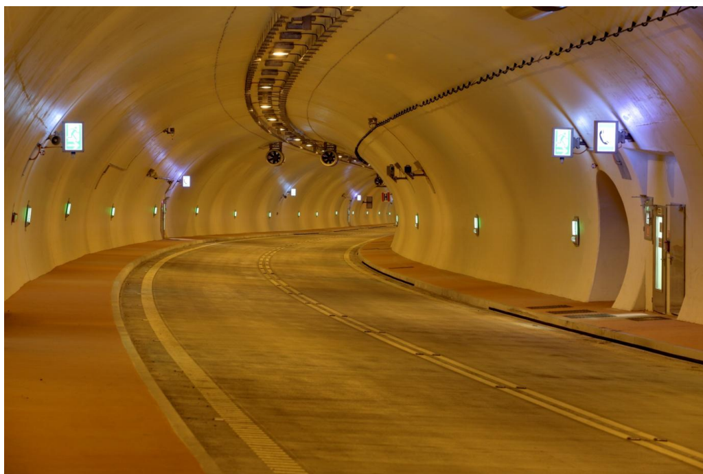
Zdj. 1 - Tunel Emilii k. miejscowości Laliki w ciągu drogi S69
